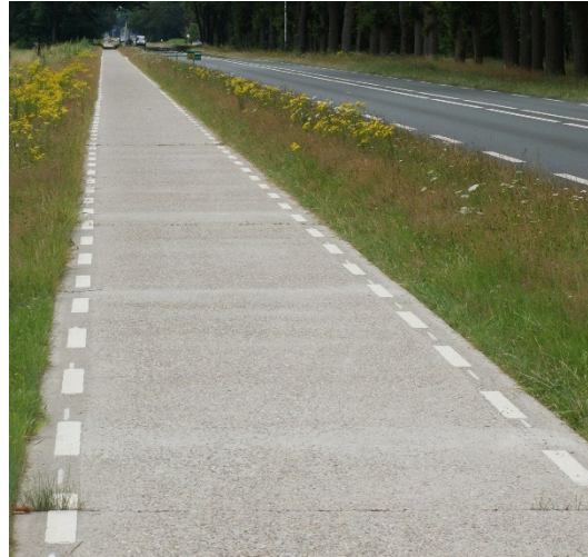
Afbeelding 25 Oppervlakte met scaling in 2022
