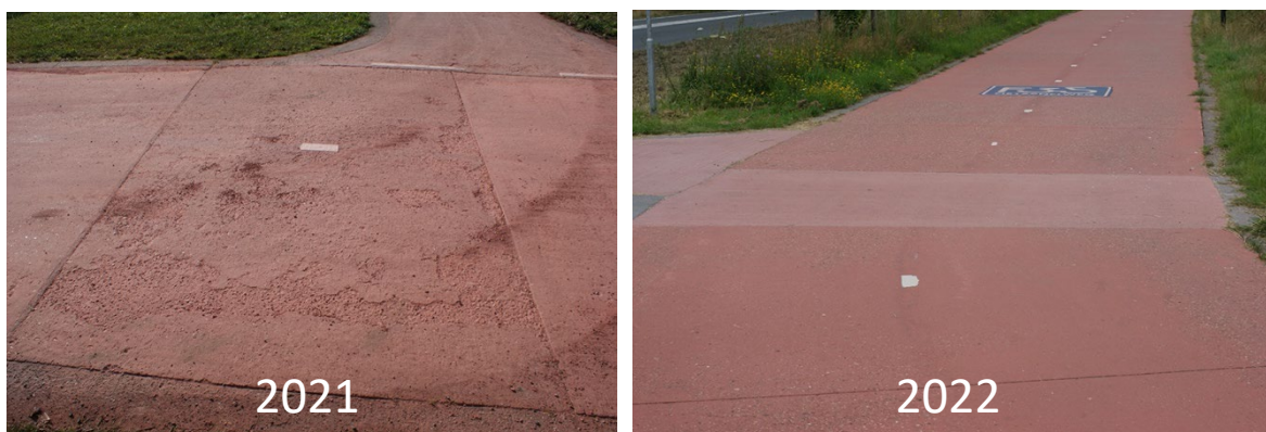
Afbeelding 20 Platen met het meest ernstige materiaalverlies zijn vervangen
