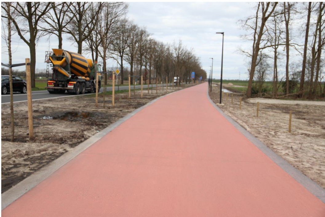
Afbeelding 15 Overzicht van het fietspad in maart 2020
