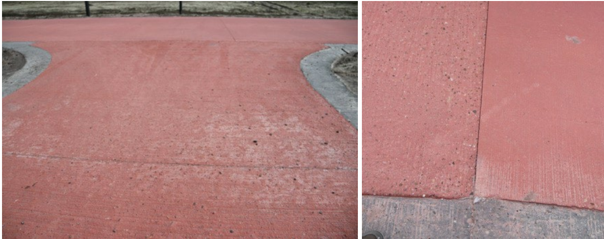
Afbeelding 16 Verschil tussen machinaal- en handmatig aangebracht (2020)
