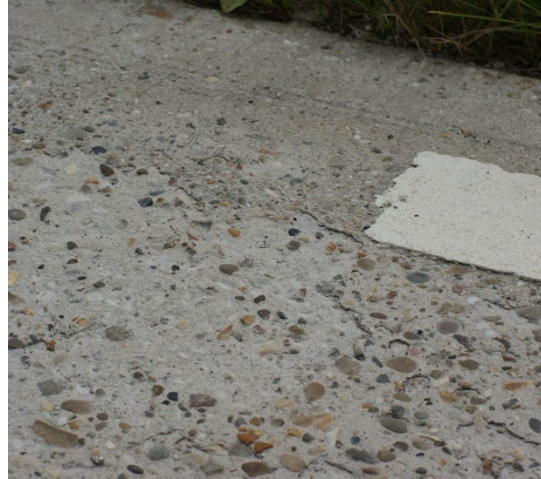
Afbeelding 31 Progressieve scaling Deventer-Holten
