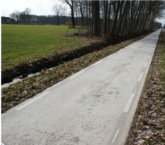
Afbeelding 24 Oppervlakte met scaling in 2021
