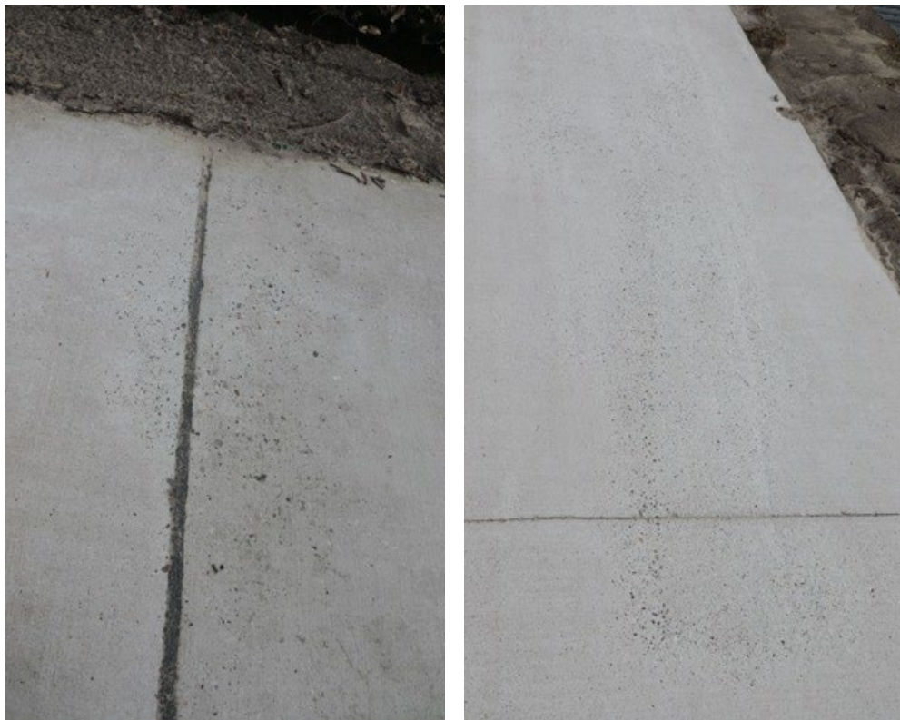
Afbeelding 23 Maart 2020: Noord- en zuidzijde: materiaalverlies al zichtbaar
