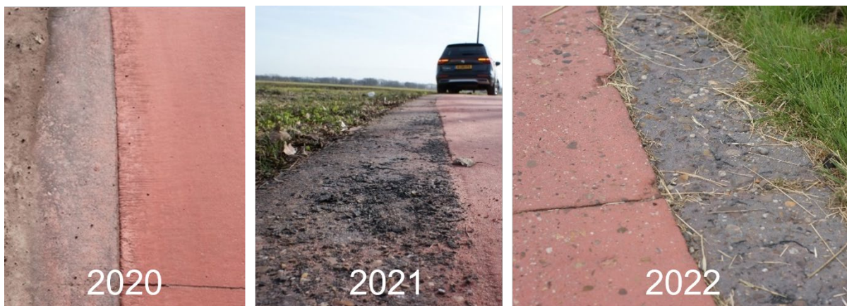
Afbeelding 19 Scaling van de opsluitband aan de onderzijde in de tijd
