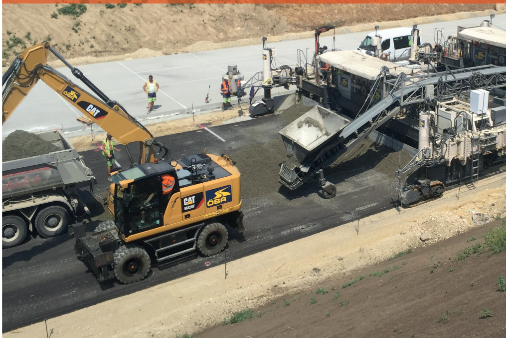
Aanleg van autosnelweg in twee lagen samengevoegd beton in Oostenrijk © Smart Minerals GmbH
