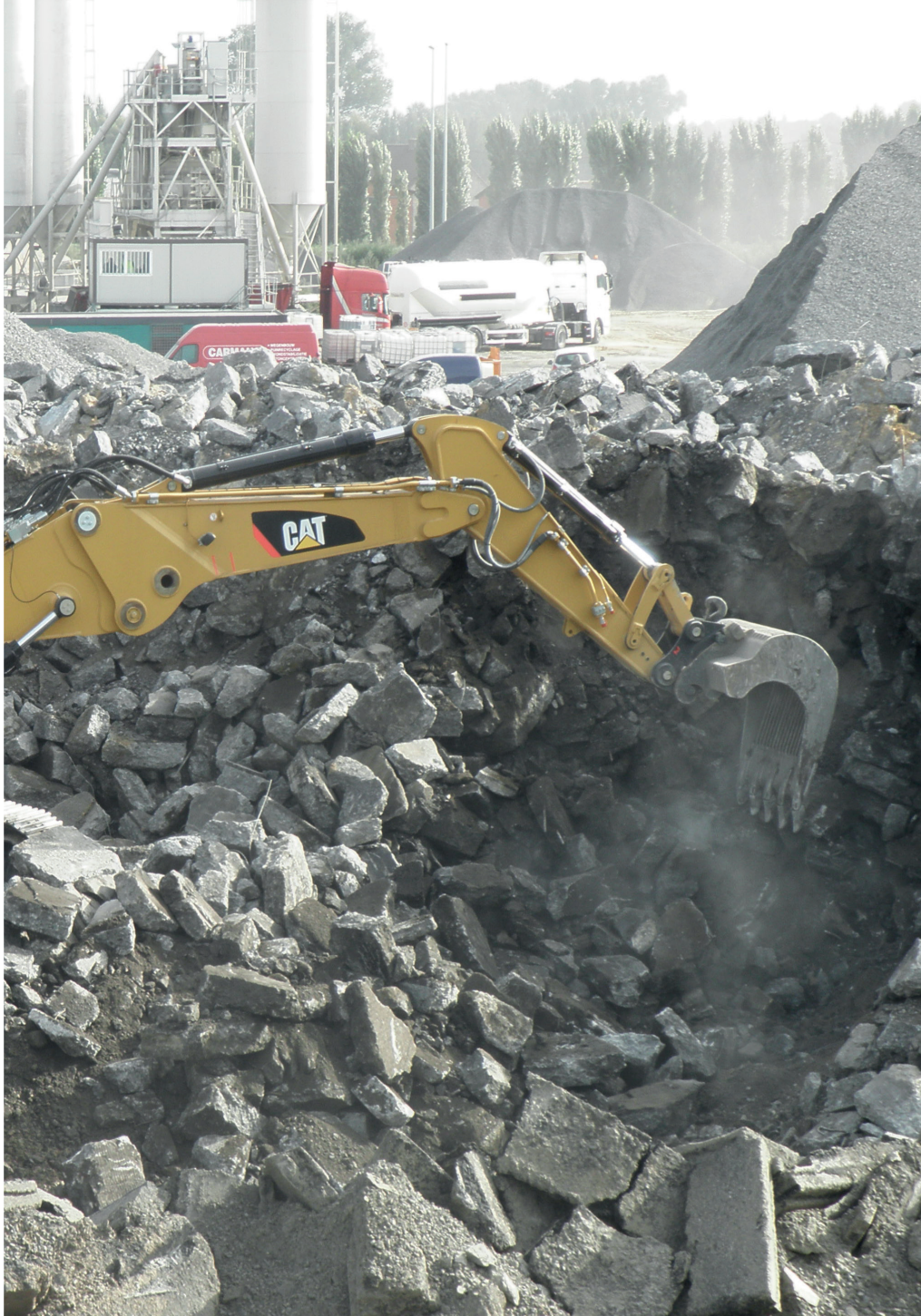
Hergebruik van betongranulaat – autosnelweg E17, De Pinte (B) © L. Rens / FEBELCEM
