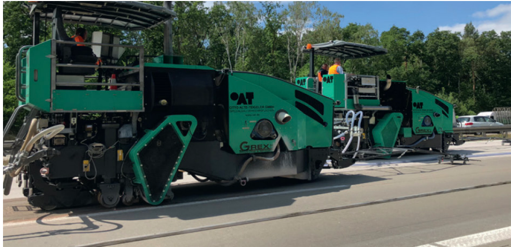
Grinding machine in dienst en een afgewerkt, zeer geluidsarm oppervlak dankzij de techniek van "Next Generation Concrete Surface"
