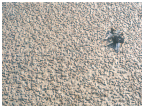
Fijn uitgewassen beton
