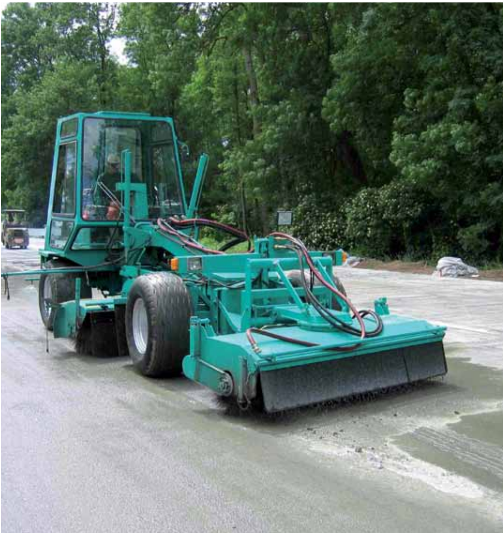
Uitborstelen van beton
