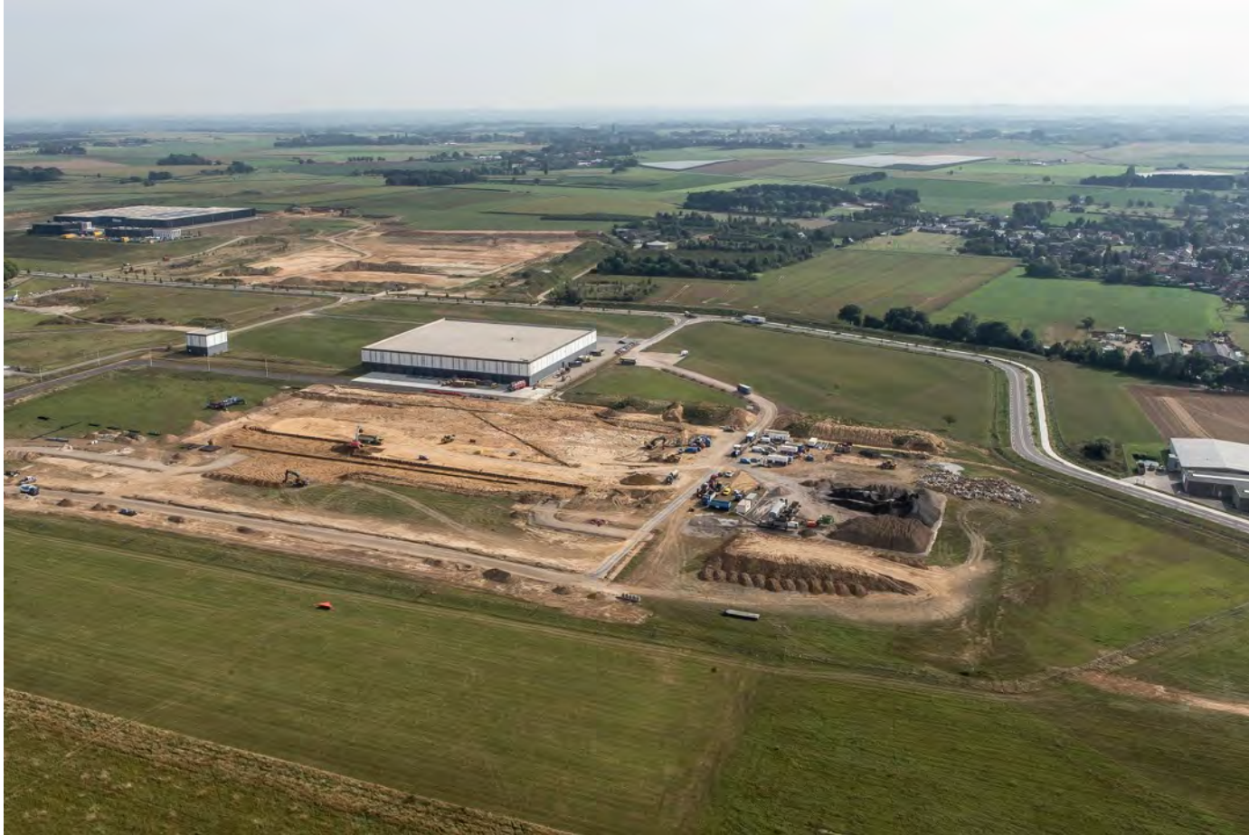
Luchtfoto van 22 september 2016
